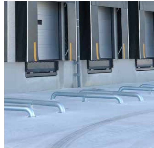
Guias de alinhamento do caminhão galvanizadas, facilita a sua entrada na doca.
